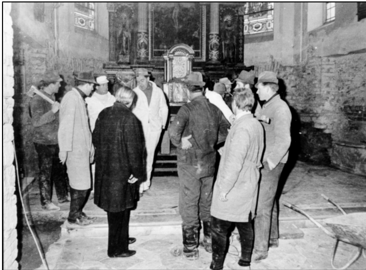
Innenarbeiten in der Pfarrkirche
