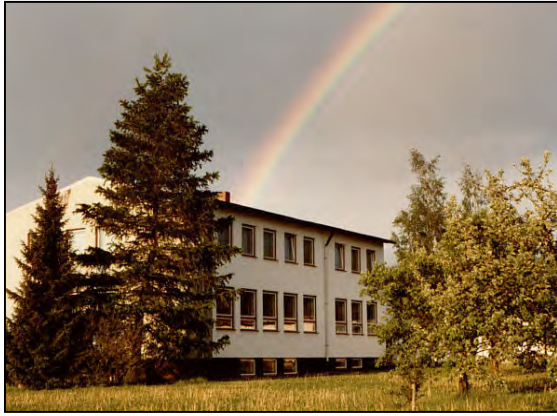
Der Kindergarten vor dem Umbau
