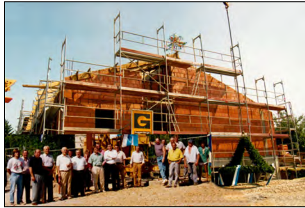
Der Erweiterungsbau beim Richtfest 1993
