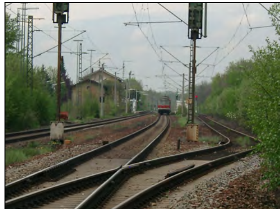
Gleis und Weichenanlagen bei Köfering
